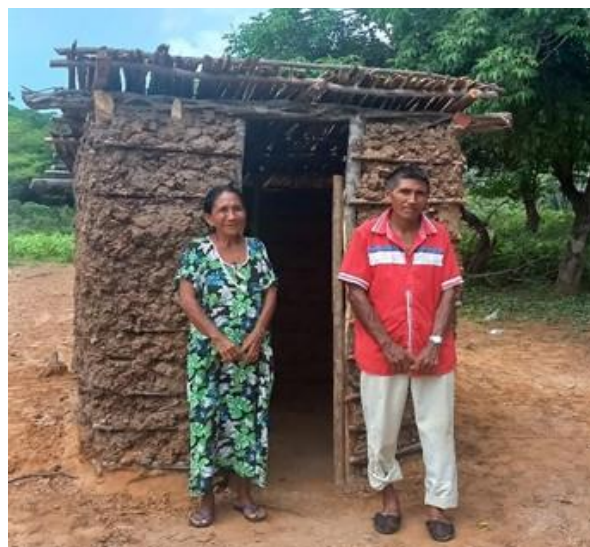
Otra familia en Panerrakat II, que ya casi finalizan la construcción de su sanitario con ladrillo, barro y Yotojoro. Mencionan que están muy motivados para iniciar a usarlo.
